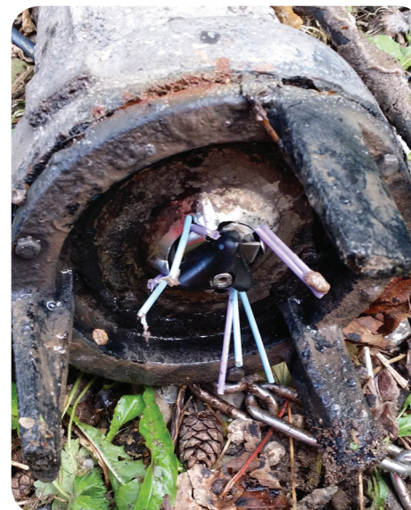
Vatpinde sætter sig nemt fast i spildevandspumperne. ▲
