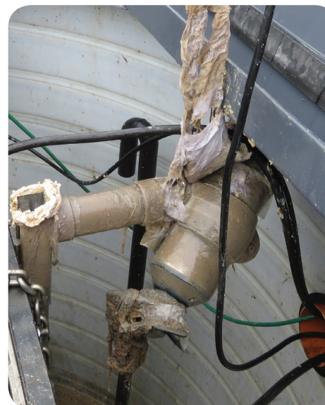
Vådservietter og engangsklude har tilstoppet en pumpestation. ▲
