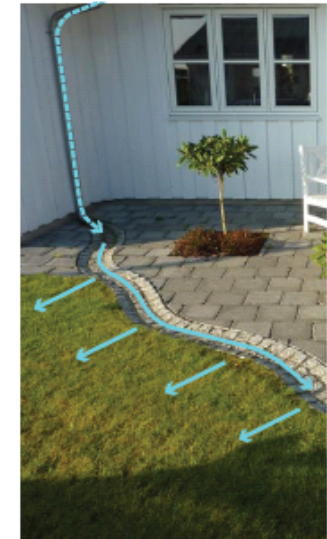
Figur 6: Regnvand ledes i en tæt rende bort fra huset til nedsvivning i græsplænen. Trekroner, Roskilde. Foto Orbicon.
