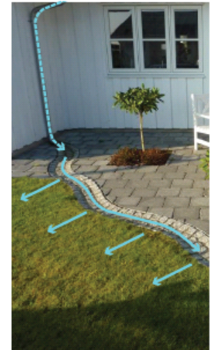
Figur 6: Regnvand ledes i en tæt rende bort fra huset til nedsivning i græsplænen. Trekroner, Roskilde. Foto Orbicon.
