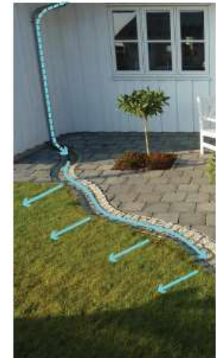
Figur 6: Regnvand ledes i en tæt rende borte fra huset til nedsivning i græsplænen. Trekroner, Roskilde. Foto Orbicon.
