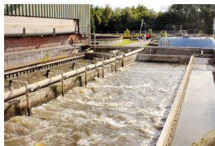
Sandfang på Hadsten Renseanlæg
